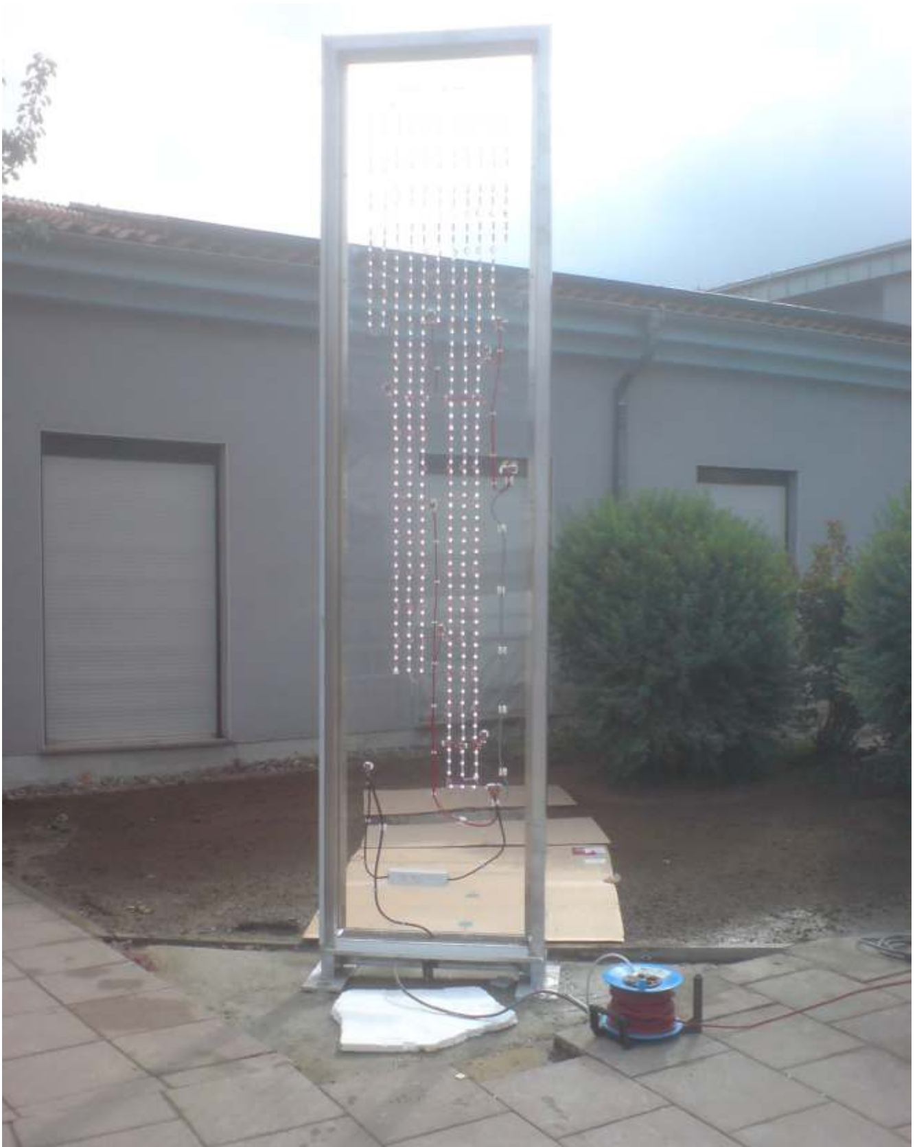
Beleuchtung eines Pylons mit LED
