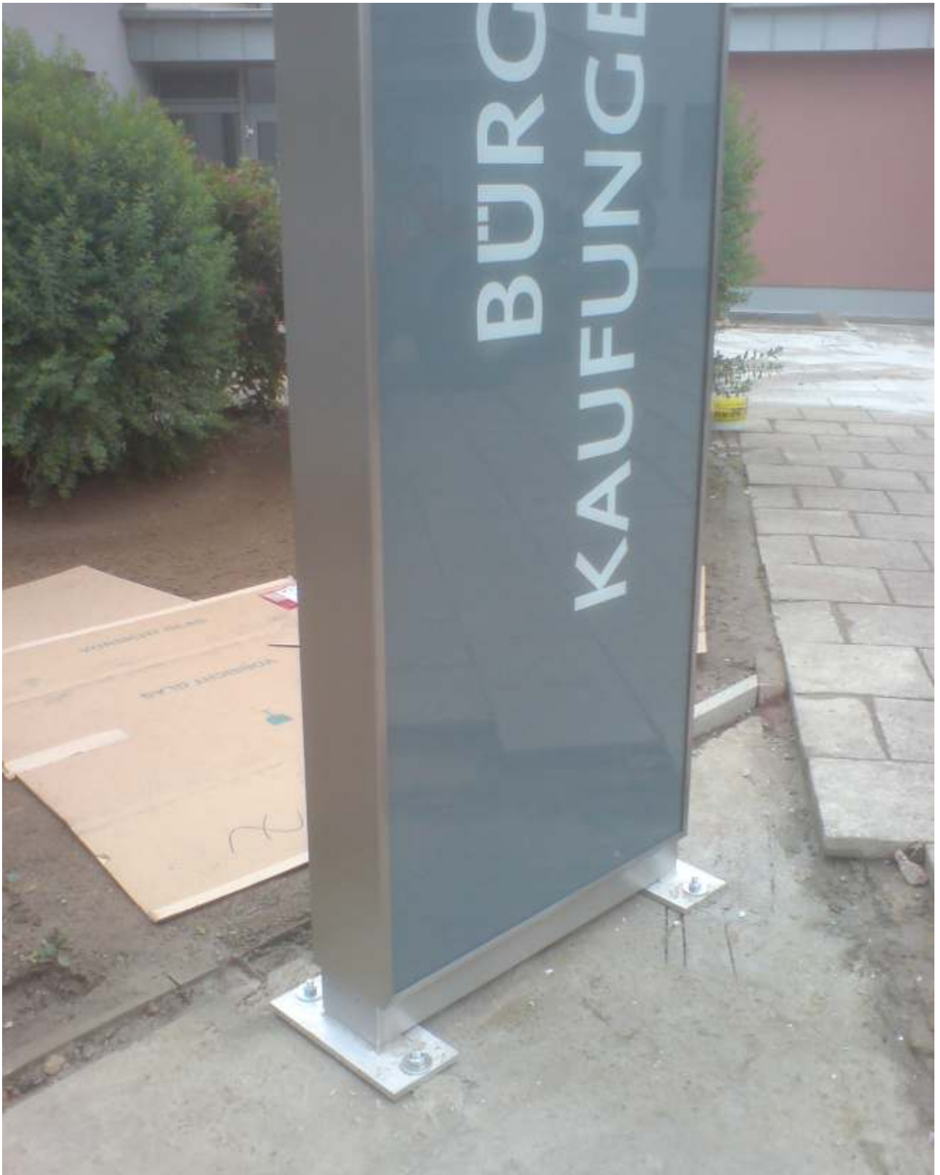
Montage mittels Flanschplatten auf bestehendem Fundament
